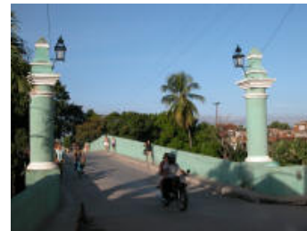
Puente sobre el Río Yayabo
