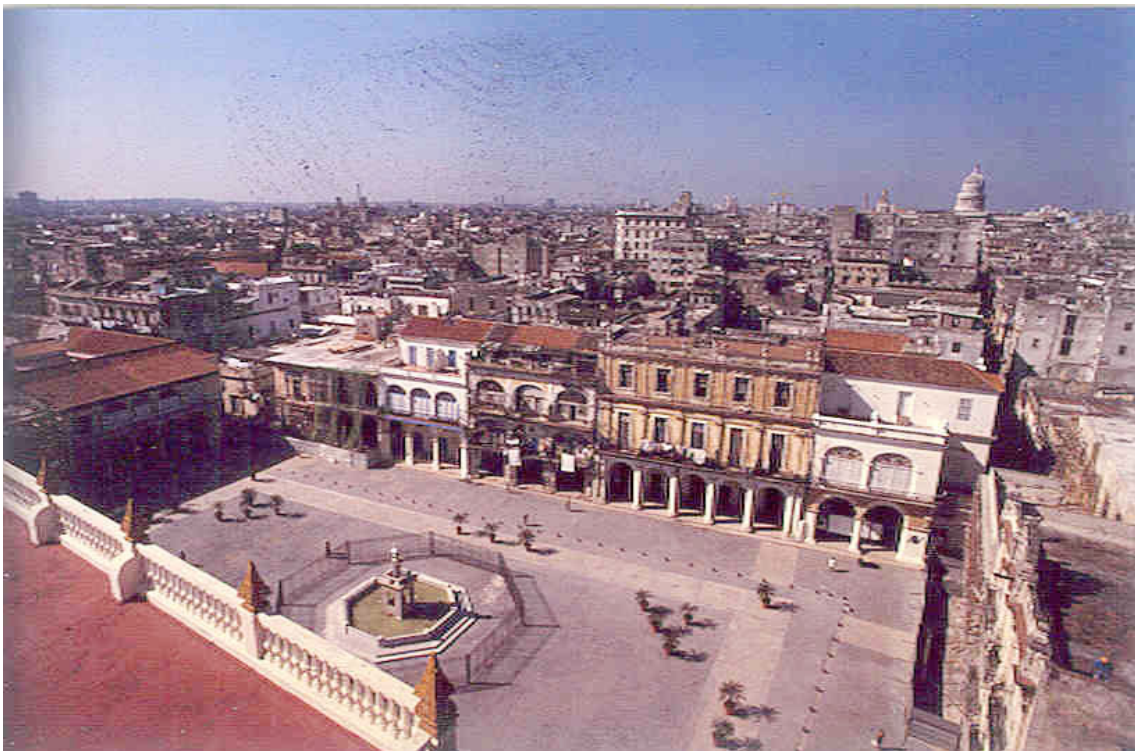
PLAZA VIEJA (En proceso final de restauración)
