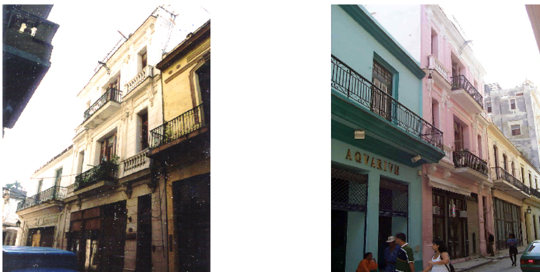
Ejemplo de rehabilitación de vivienda: Brasil No.11 (antes y después)
