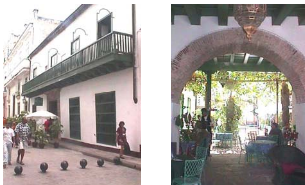
Fig.2.26: Oficinas 12, fachada y vista del zaguan
