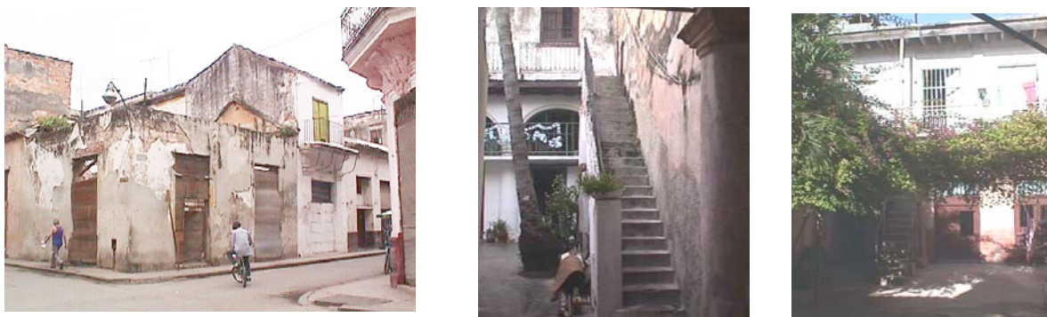
Fig. 2.21: Cuartos altos en casas bajas. Izq. Cuarto sobre zaguán en Cuba 672, centro y derecha, cuartos sobre obras traviesas, en Sol 318 y en Inquisidor 456
