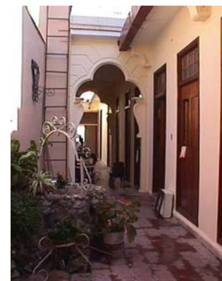
Fig. 2.11: Amargura 255, fachada y vista desde el fondo del patio interior
