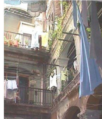
Fig. 2.37: Teniente Rey 113, patio interior
