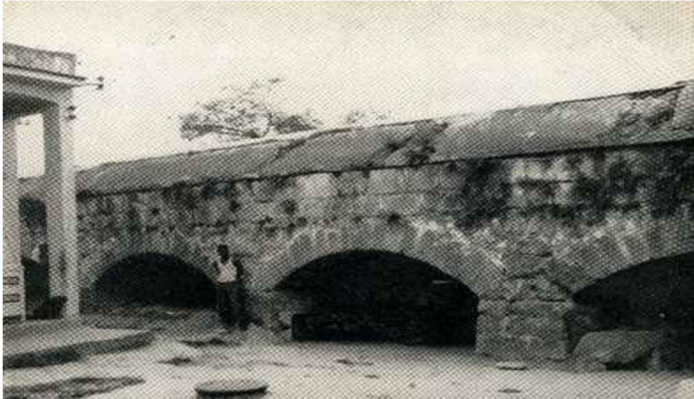
Foto del Acueducto de Fernando VII, en la barriada del Cerro.
