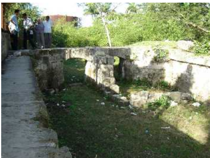
Restos del canal de toma
