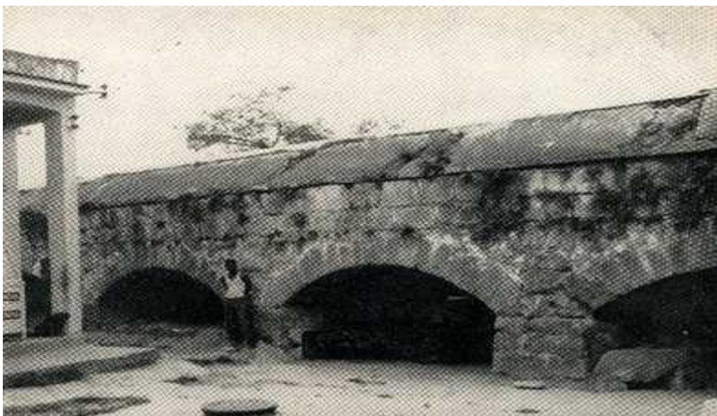
Anexo No. 21 Tramo de tubería del Acueducto Fernando VII
