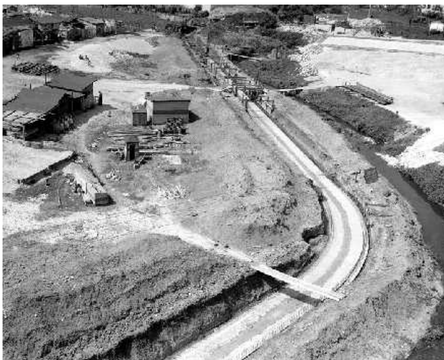
Anexo No. 16 Entubamiento de una de las derivaciones de la Zanja Real cerca del Estadio del Cerro. Año 1949
