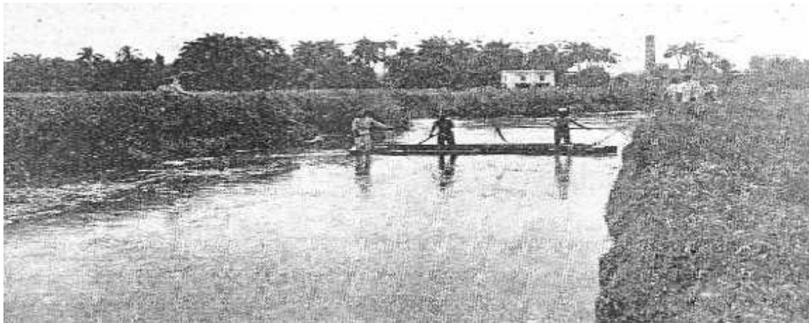
Foto de trabajos de limpieza en la Zanja Real.
