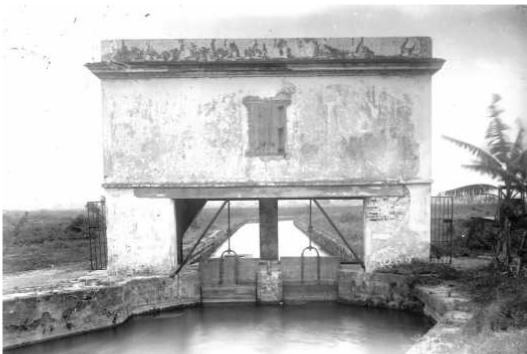
Anexo No. 6 Casa de Compuertas de la Zanja Real en El Husillo
