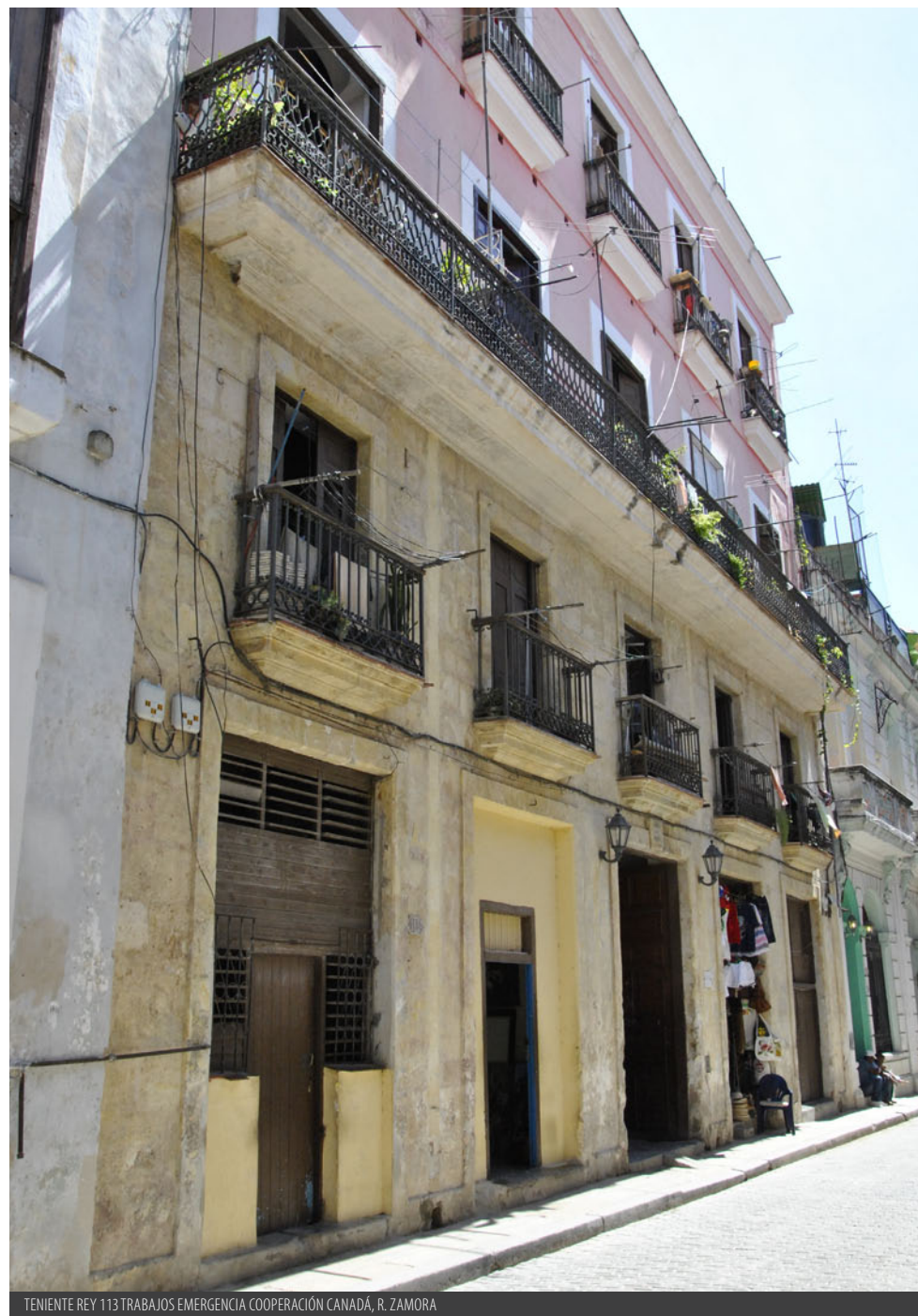
TENIENTE REY 113 TRABAJOS EMERGENCIA COOPERACIÓN CANADÁ, R. ZAMORA
