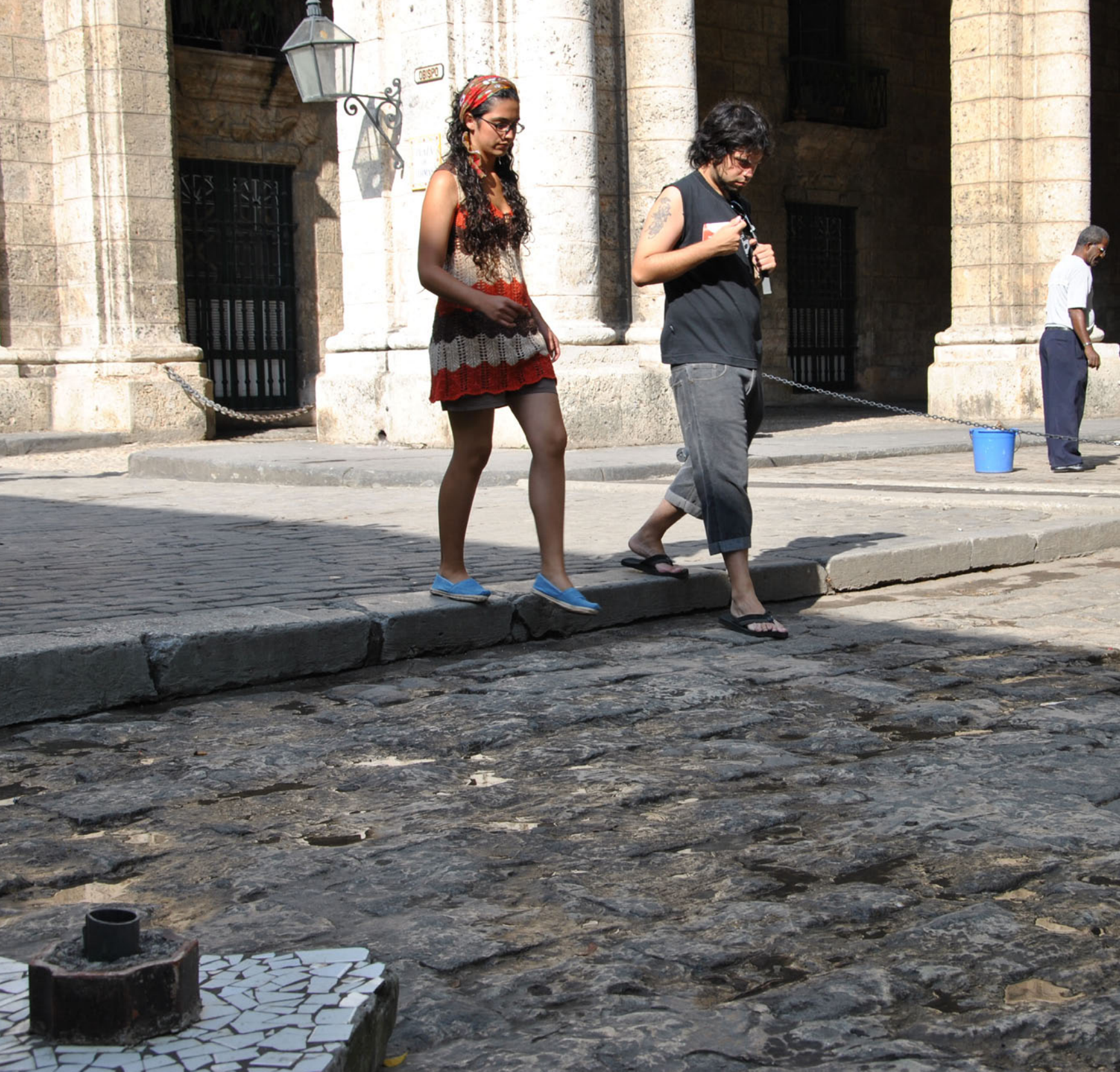
2.4. ESPACIO PÚBLICO / 2.4.4. ACCESIBILIDAD UNIVERSAL DIFERENCIA DE NIVELES PAVIMENTO, R. ZAMORA
