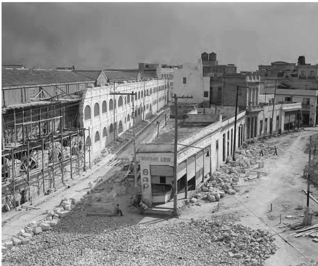
Figura 86. Obras de ensanche en la avenida Desamparados.
