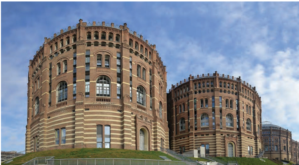
Figura 39. Gasómetros de Viena. Su rehabilitación recuperó un elemento industrial importante para la ciudad (funcional, patrimonial y paisajístico).
