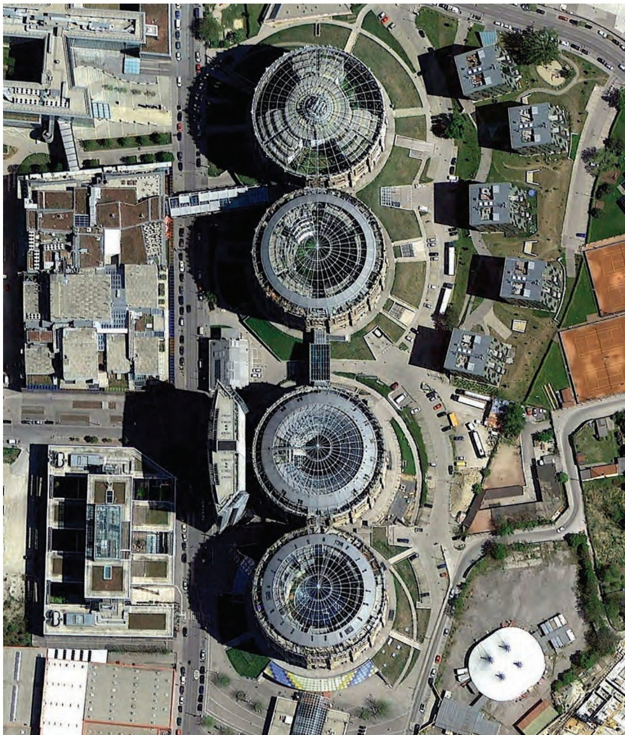
Figura 40. Vista área de los gasómetros.
