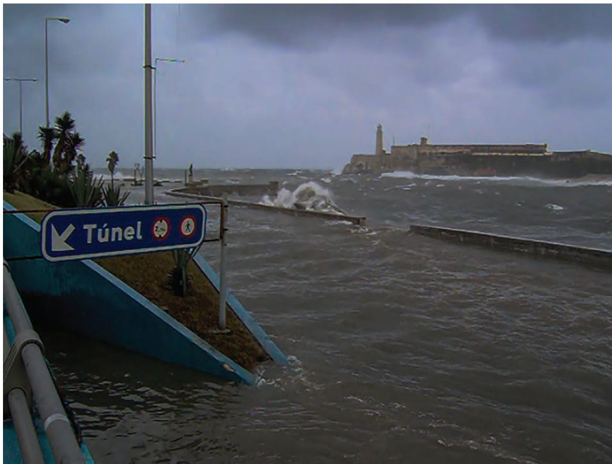
Figura 88. Inundaciones por penetraciones del mar durante el ciclón Wilma, 2005.
