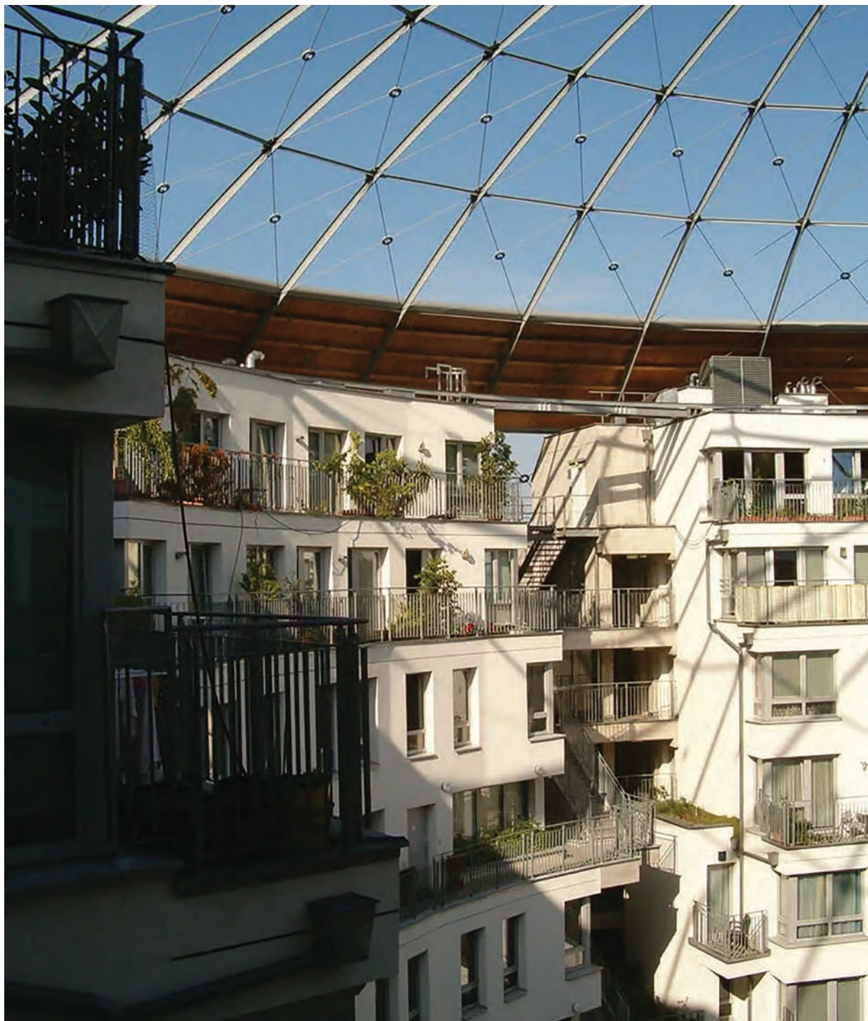
Figura 41. Patio interior coronado con una cúpula de vidrio del edificio de viviendas proyectado por Arq. Jean Nouvel.
