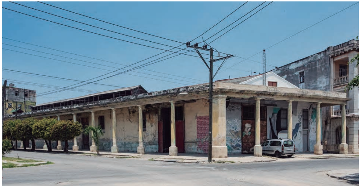
Figura 66. Estudio 50. Imagen de la fachada. Se destaca el portal público que rodea a la instalación franqueado por columnas de hierro fundido y la cubierta con su monitor central.
