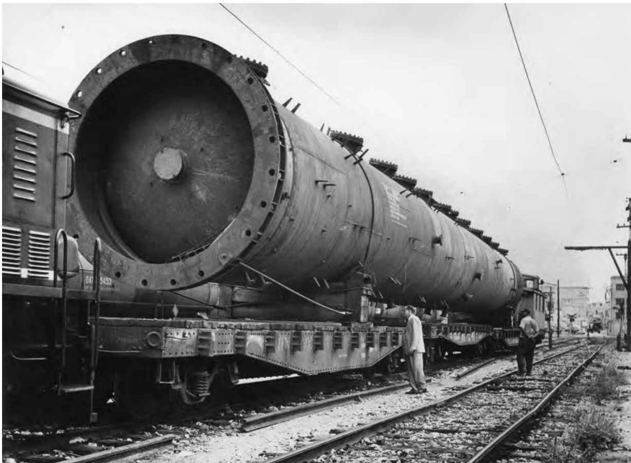
Figura 85. Piezas de la Refinería ESSO-Belot transportadas por ferrocarril.
