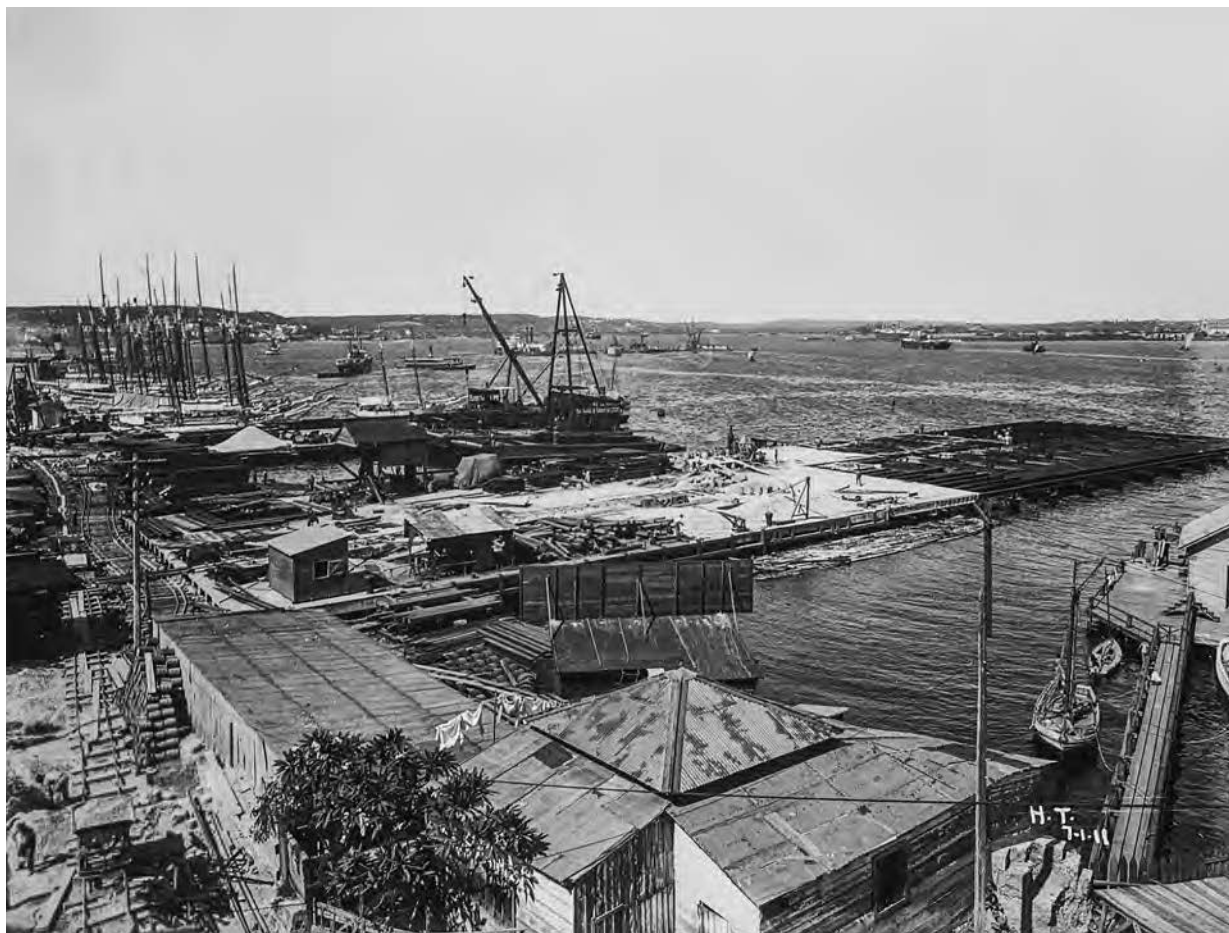
Figura 78. Construcción del muelle de Paula con estructura de acero a principios del siglo xx.
