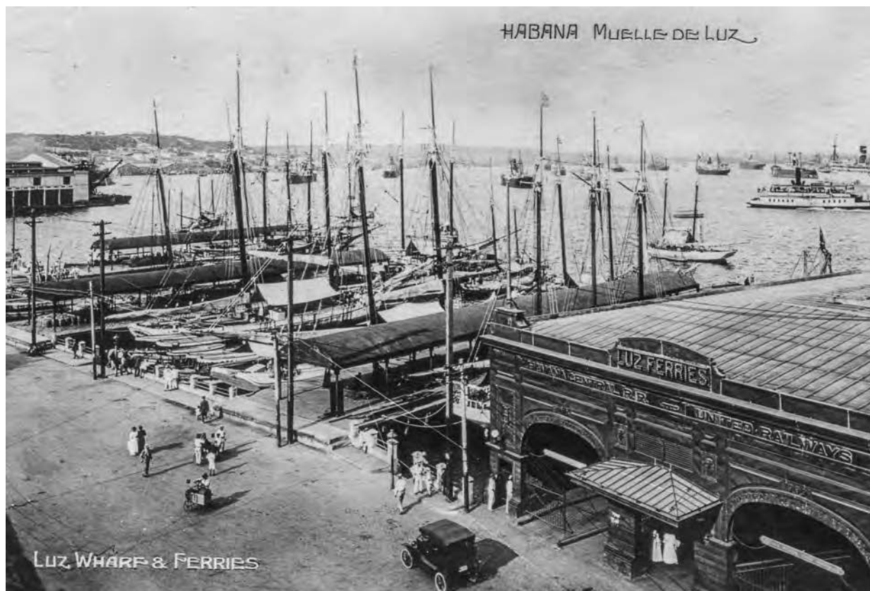
Figura 84. Estación de ferries en el muelle de Luz a principios del siglo xx.
