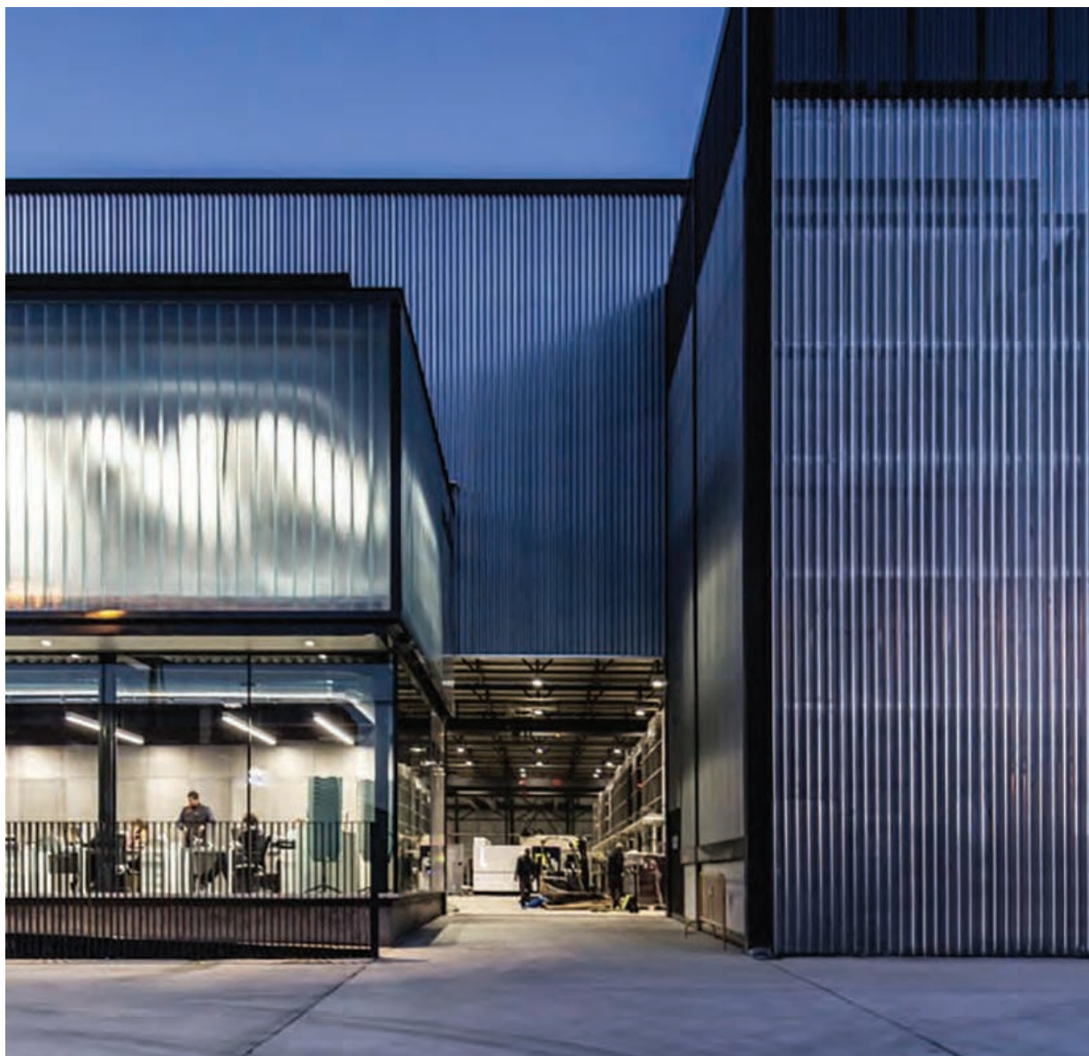
Figura 11. Uso del bardage a manera de piel en los edificios industriales que logra la integración del mismo al paisaje urbano. Cortes Metalúrgicos, Oviedo. Arquitecto Oscar Miguel Ares Álvarez.
