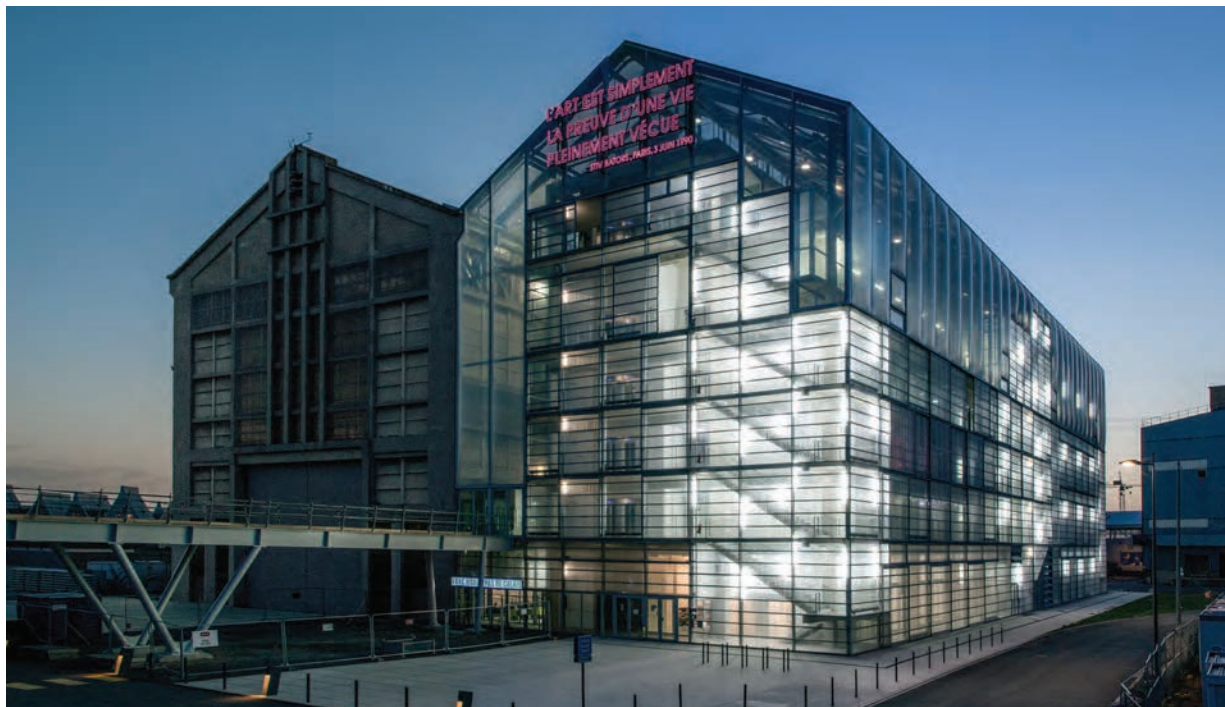
Figura 35. FRAC Nord-Pas de Calais en Dunkerque. Junto a la antigua nave industrial se ha replicado otra con materiales y envoltura diferentes, creando un conjunto multifuncional y cultural que alcanza diferentes escalas.
