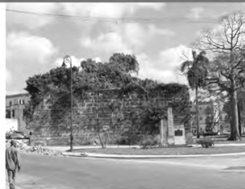
Restos de la muralla
